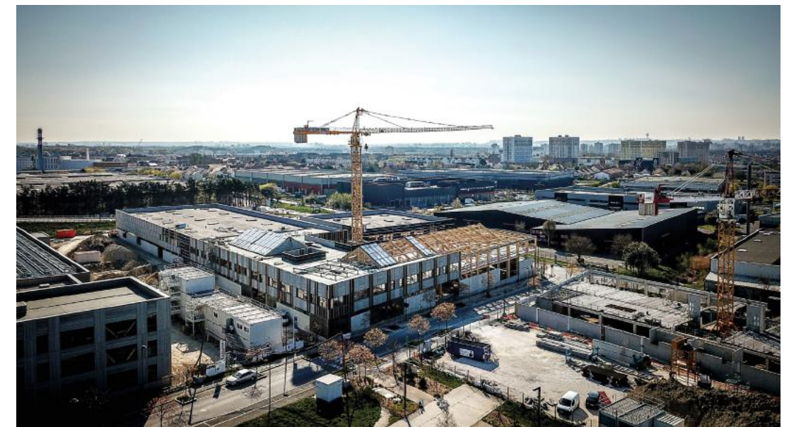
Avancement rapide du chantier de novembre 2019 à avril 2020.
